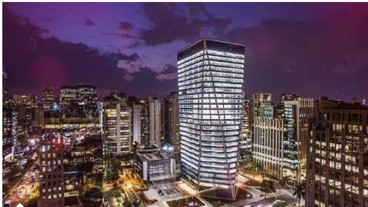
EDIFÍCIO B32 B32 BUILDING
